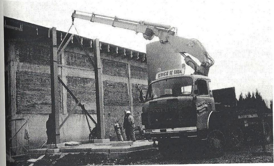
Deutlich sichtbar ist die angetriebene, erste Achse des Saurer D330BF8x6.
